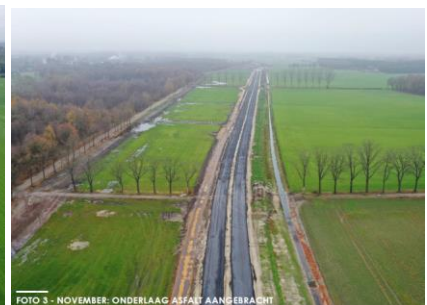
FOTO 3 - NOVEMBER: ONDERLAAG ASFALT AANGEBRACHT
