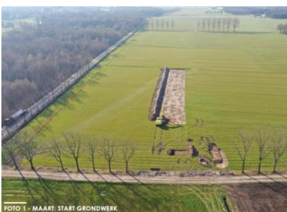
FOTO 1 - MAART: START GRONDWERK
