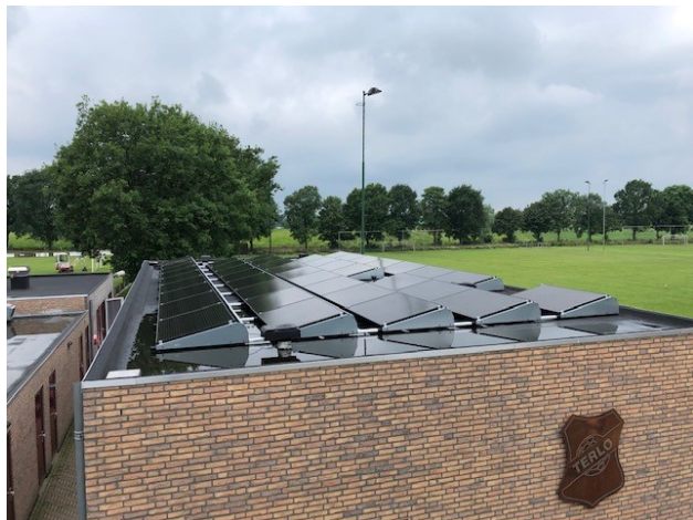
Zonnepanelen voetbalvereniging Terlo in Bergeijk
